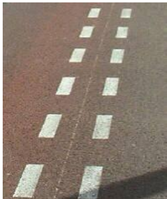
Exemple de réalisation
