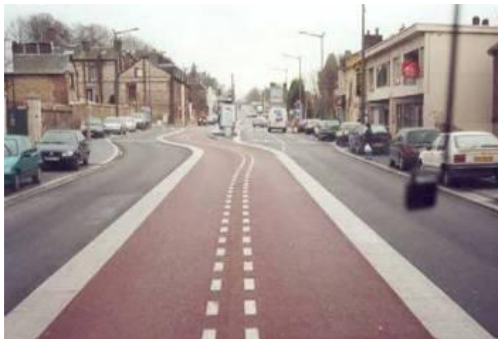
Tracé avec matérialisation du gabarit limite d'obstacle, cas d'un transport guidé (TEOR)
